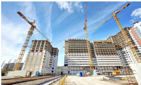
Строительство жилья, производство строительных материалов
